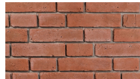
ściana wykończona płytką ceramiczną cegłopodobną z fugą przykładowo monsanto 1 red firmy STEGU gr 7-26mm
